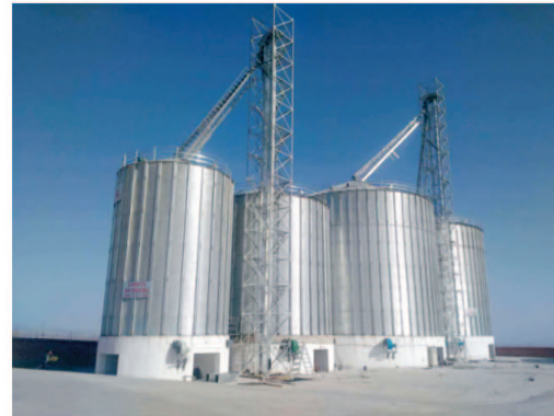
水泥基础筒仓 Cement base silo
