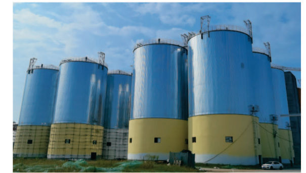
水泥锥底仓 Cement cone bottom silo
